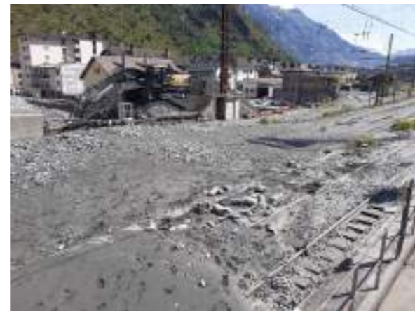
Crue du Charmaix du 30.06.25 : voie ferrée et chenal engravés
